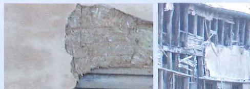
Anciennement, l'enduit de chaux recouvrait une structure légère faite de poutres et de clins de bois.
